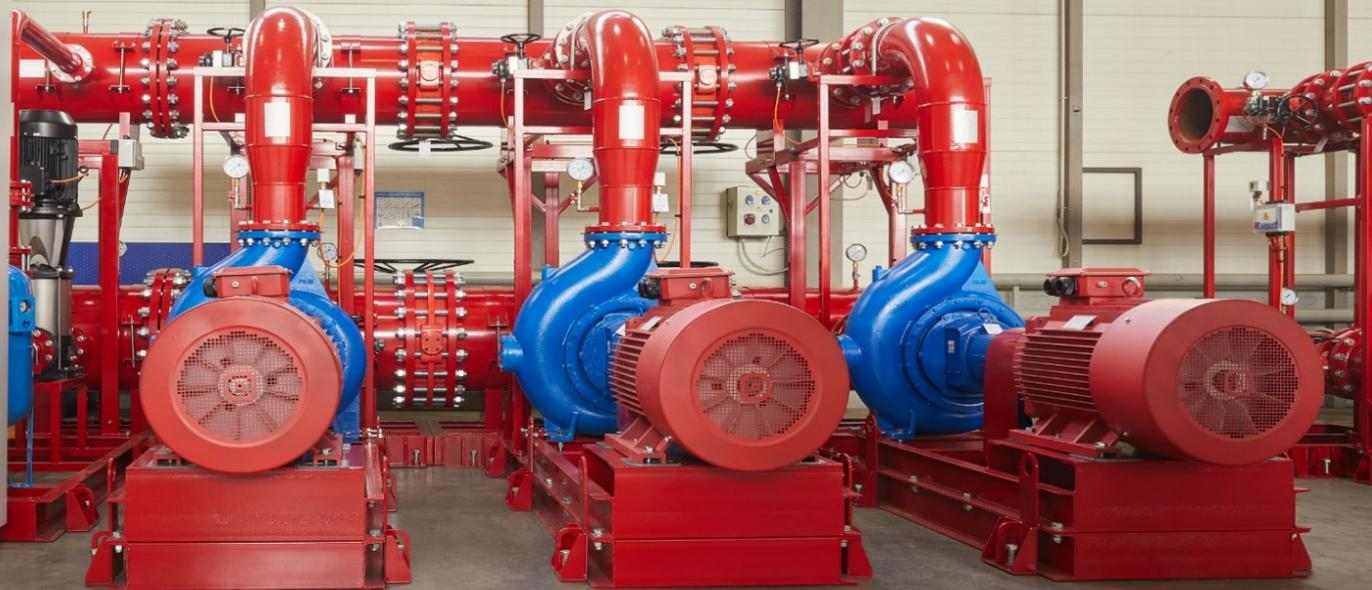
Диаметр коллектора – 500/600 мм, Расход – 1317м<sup>3</sup>/ч, Напор – 45 м
