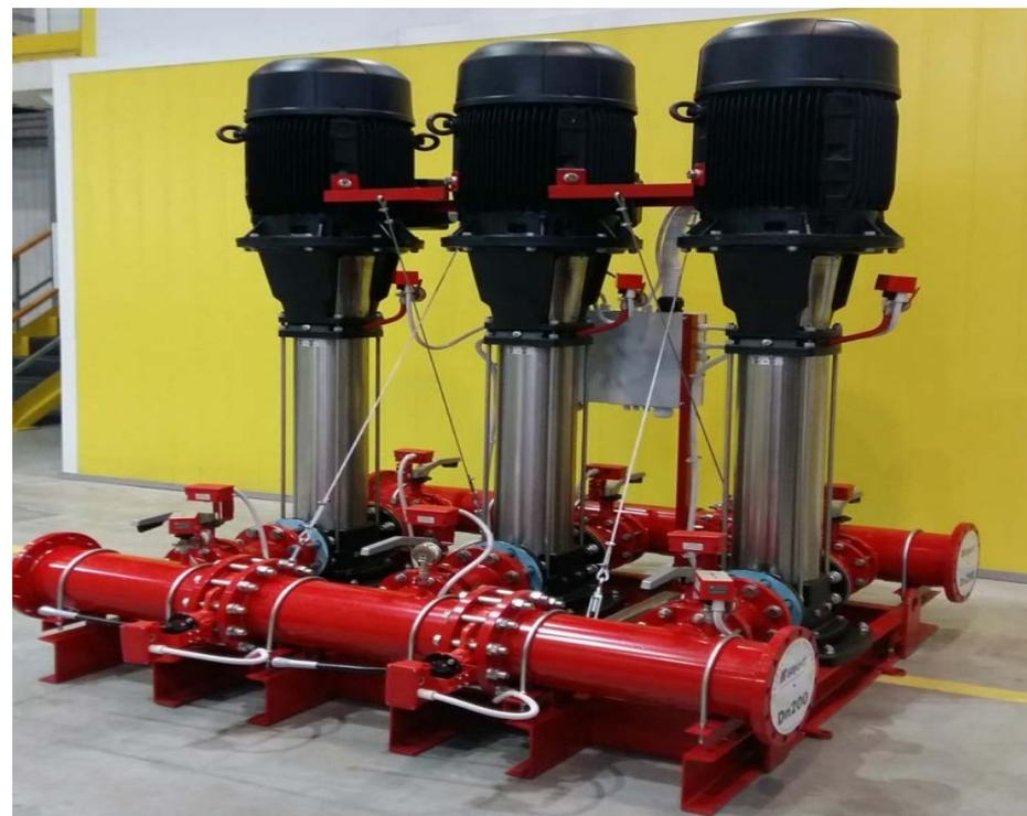
Диаметр коллектора – 200 мм
