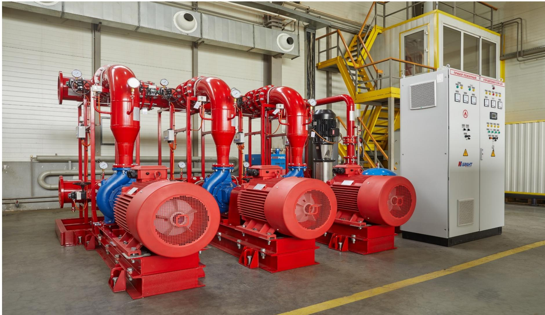
Диаметр коллектора – 300 мм, Расход – 1100 м<sup>3</sup>/ч, Напор – 70,6 м
